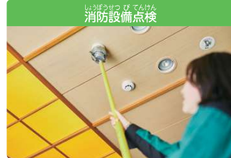
消防設備点検 火災報知器や消火器が正しく使用できるかチェック項目に従って確認します。
